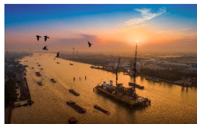
上海昆阳路越江大桥工程
