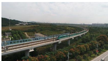
南京至高淳城际轨道南京南站至禄口机场段工程
