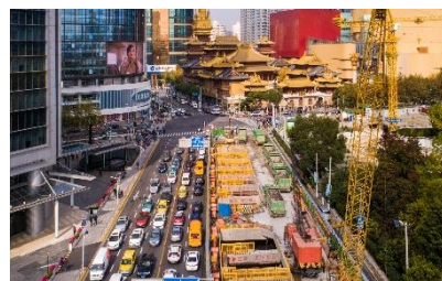
上海轨道交通14号线工程
