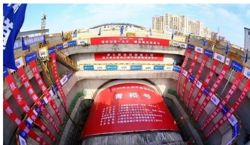
相继完成S26入城段高架、诸光路隧道贯通等任务
