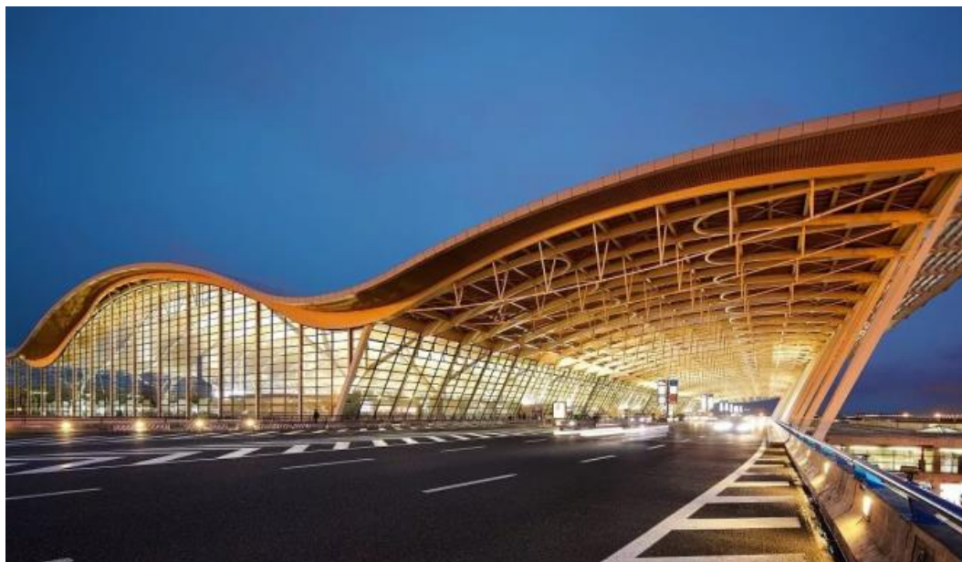
完成浦东机场主进场路系统修缮工程任务，打通了浦东机场的必经“咽喉路”
