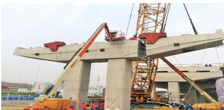
S26公路 环保新工艺—由隧道股份城建设计集团设计，市政集团承建的S26入城段国内最大盖梁成功拼装。
