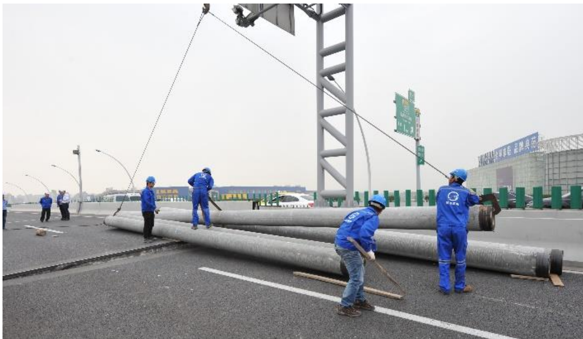
中环线沪太路内圈高架道路因突发重大交通事故，造成桥面位移，仅用13天时间完成应急抢险。
