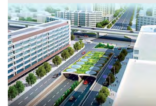
湖北武汉三阳路隧道
