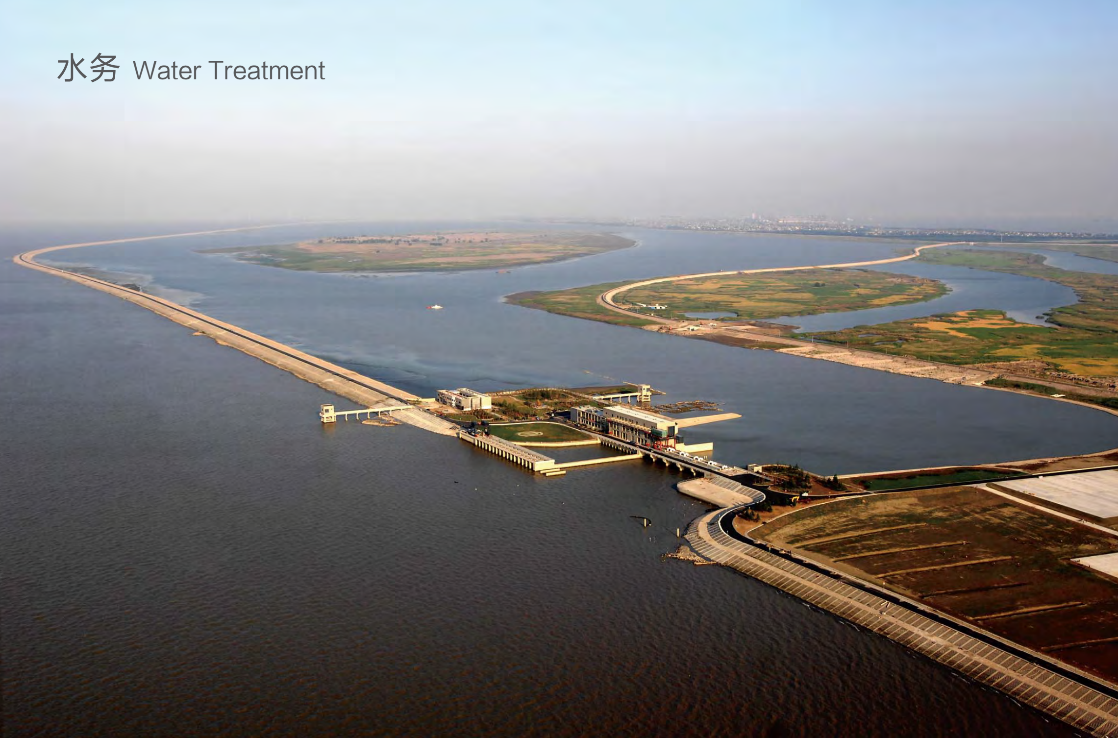
上海青草沙水源原水工程
