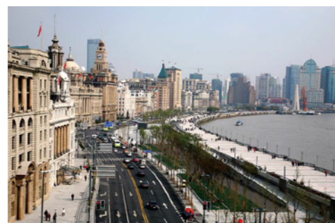
在世界首个复杂地况超大型隧道——上海外滩隧道建设中，我们运用特殊防护措施和一流地下穿越技术，确保上海“外滩万国建筑群”延续经典。
