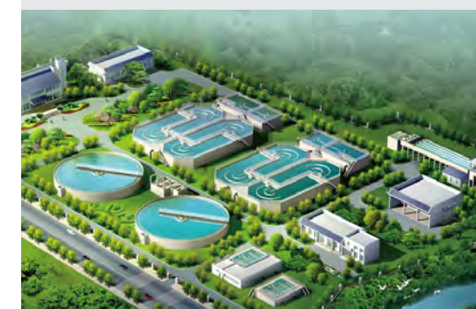
四川都江堰青城山污水处理厂
