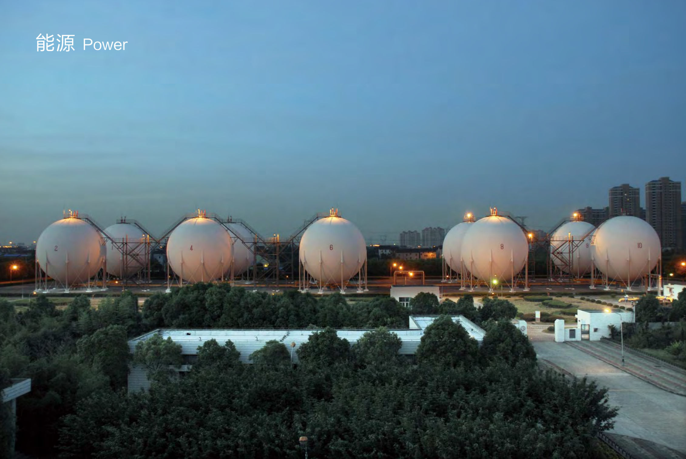
上海天然气主干网工程
