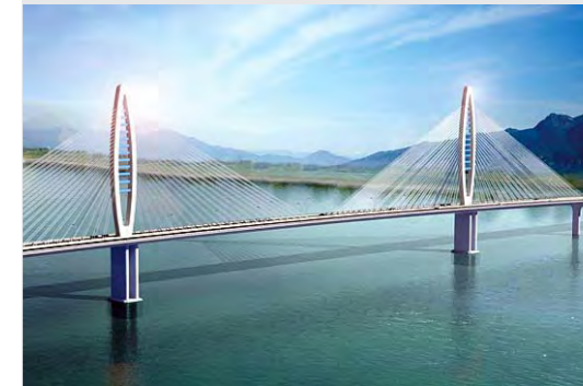
云南昆明高速立交道路
