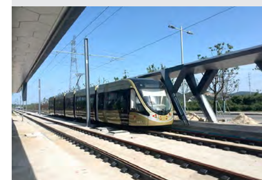
江苏苏州高新区现代有轨电车1号线
