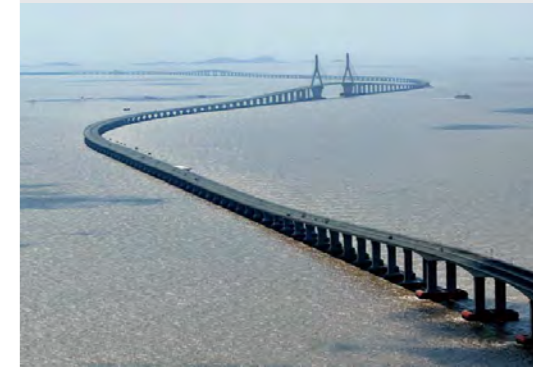
江西南昌朝阳大桥
