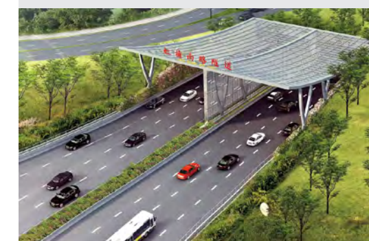
上海虹梅南路隧道
