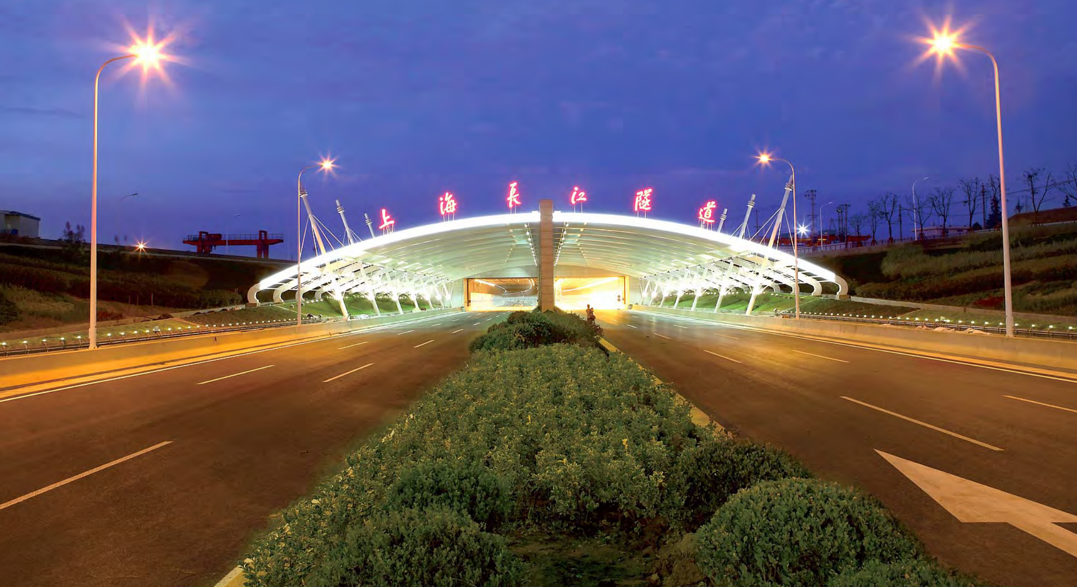
上海长江隧道
